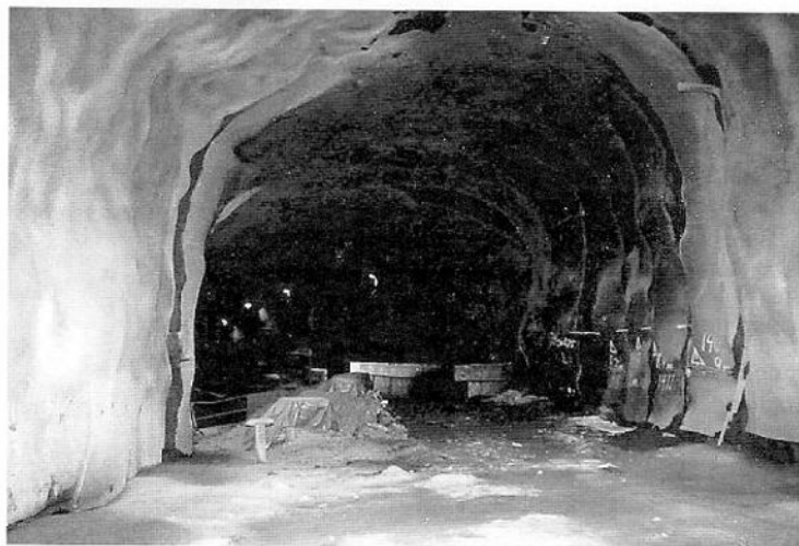
Vista dei rivestimenti in Spritz Beton dei tunnel.
